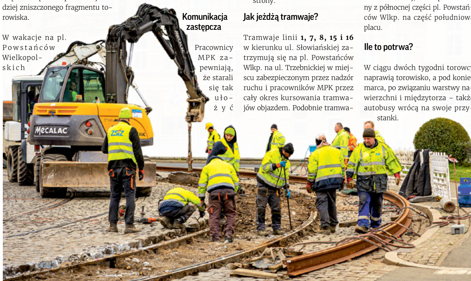
Torowcy wymieniają szyny w łuku torowiska na pl. Powstańców Wielkopolskich, by tramwaje bezawaryjnie mogły po nich kursować do wakacji
